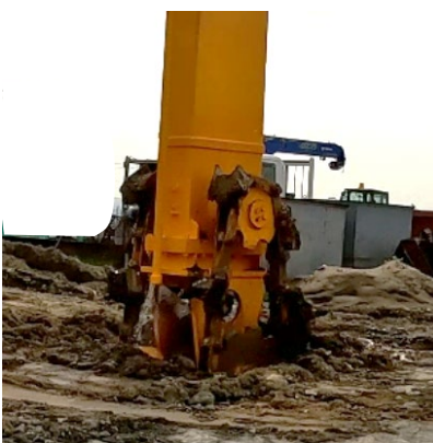
施工例 (掘削攪拌状況)
