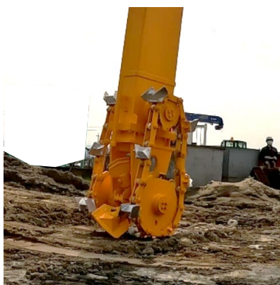
施工例 (アタッチメント部)
