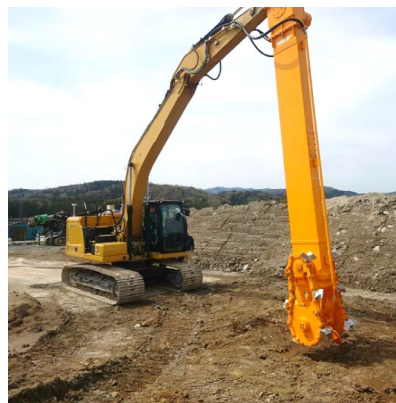
施工例 (アーム接続状況)
