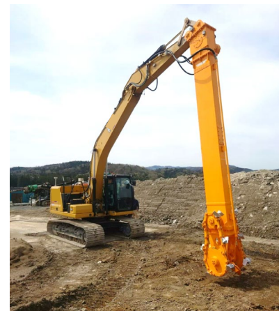
施工例 (アーム接続状況)
