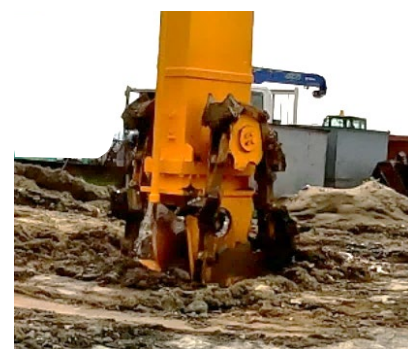
施工例 (掘削撈拌状況)
