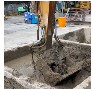
施工例 (スラリー)
