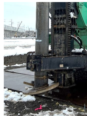
鋼管杭の打ち込み（拡大）
