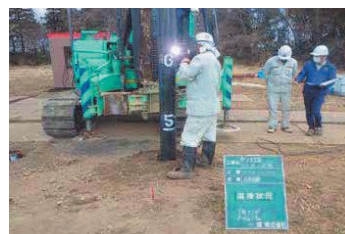
⑤ 接続 (溶接)
