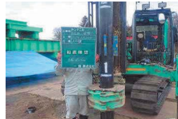
③ 建て込み確認、鉛直確認
