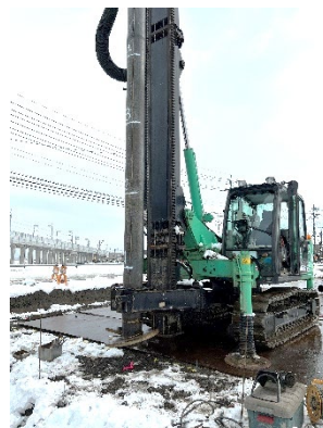
鋼管杭の打ち込み
