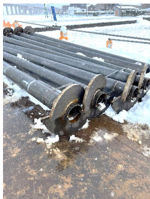
鋼管杭の翼部
