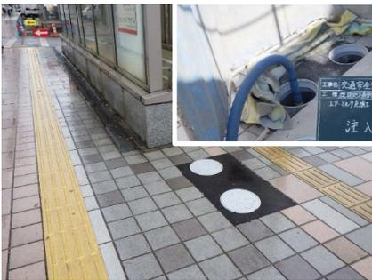
地下道の廃止による充填閉塞
