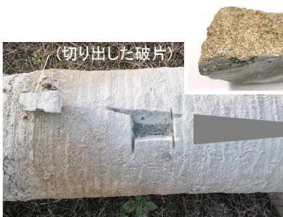
柱状体の表層部をグラインダーで切り出し
