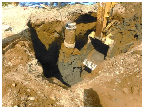
バックホウで周囲を掘削
