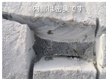
切り出し部の内部の様子
