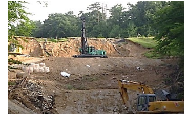
施工状況 (全景)
